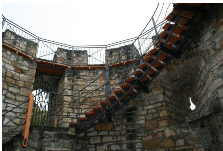
JZ bašta před instalací schodiště
