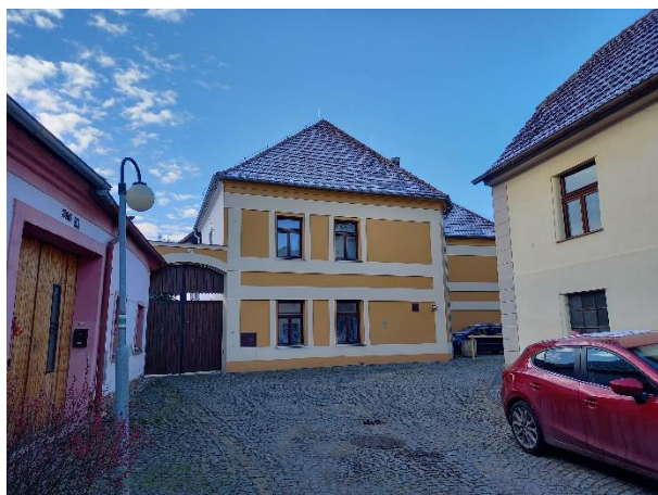
dokončení fasád na pěší zóně ul. Školská
