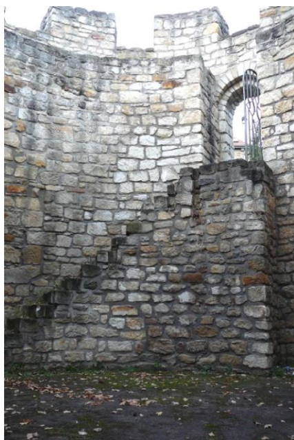
JZ bašta po instalaci schodiště
