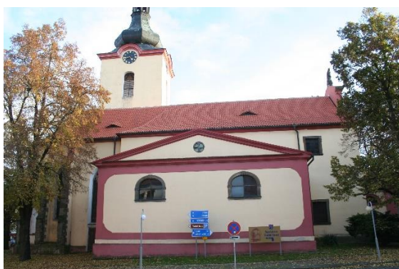
Nová krytina střechy
