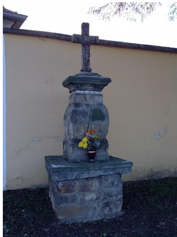
oprava drobných sakrálních staveb
